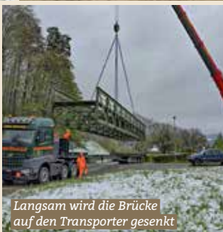
Dieser Kran wird die 20 Tonnen schwere Brücke ausheben
