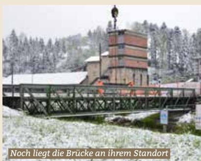
Dieser Kran wird die 20 Tonnen schwere Brücke ausheben
